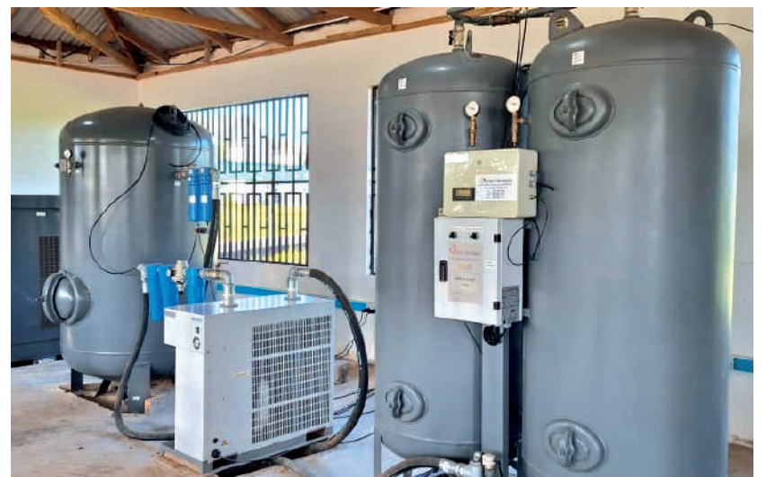
UZALISHAJI wa hewa ya Oksijeni (Oxygen Plant) katika Hospitali ya Rufaa ya Mkoa Shinyanga.
